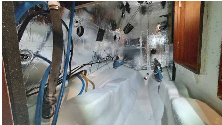
Konehuone juuri ennen koneen nostoa sisälle
